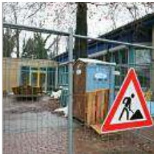
Noch ist die Mensa am Schulzentrum eine Baustelle. Die Arbeiten sollen bis in den März dauern. (Bild: RN)
